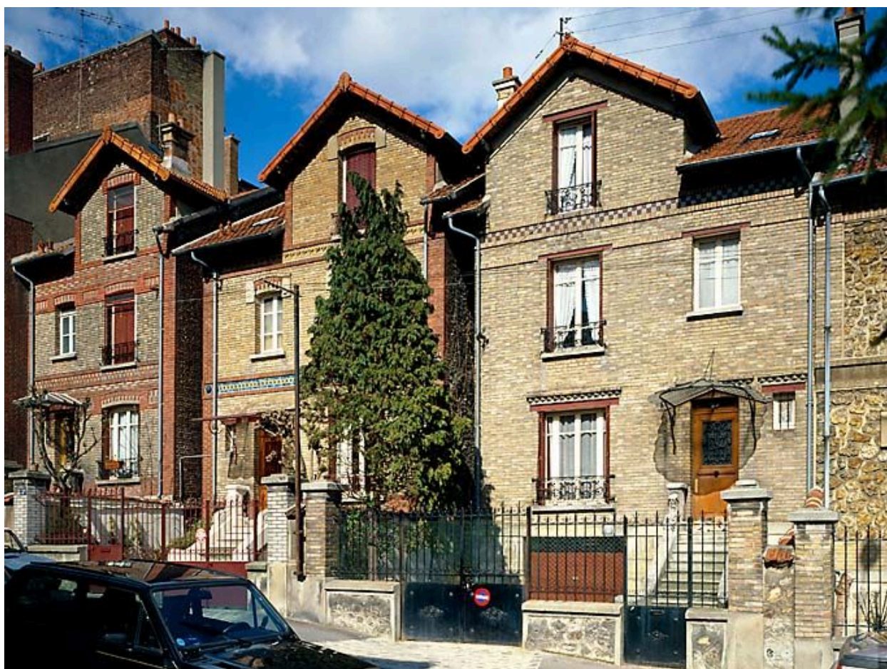
Maisons, 3-5 rue de l'Armistice. Façade antérieure.
