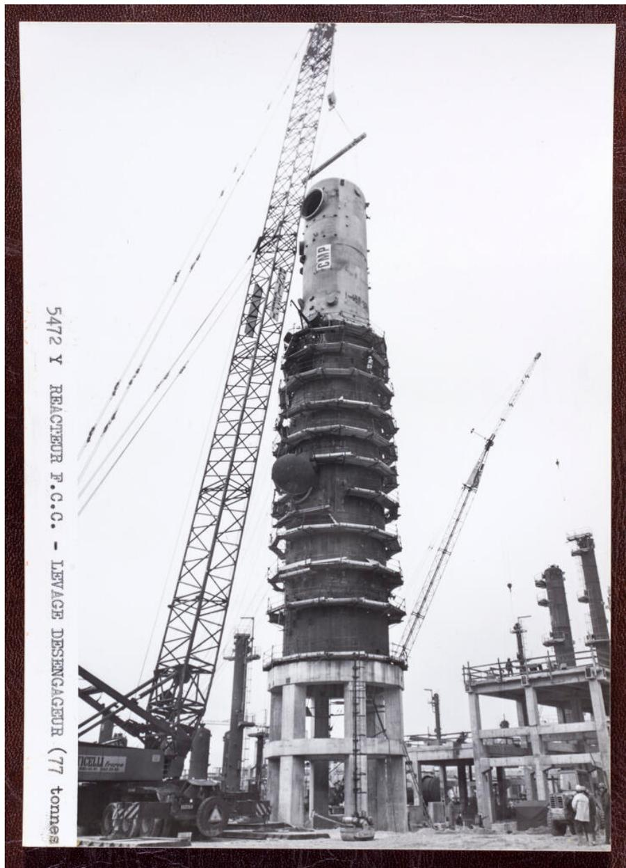
Réacteur FCC, levage désengageur (77 tonnes), sans date. Dans : Collection de photographies "Technip Chantier - Raffinerie de Grandpuits", 1977-1978, tirages noir et blanc 13x18 cm, Studio Arnoul, Nangis (Service communication TotalEnergies de la plateforme de Grandpuits-Gargenville).
