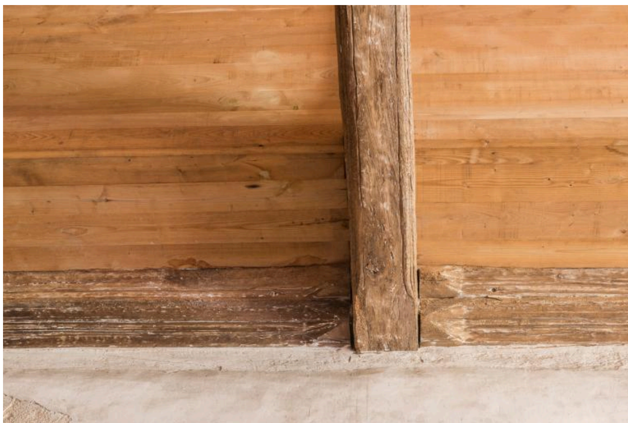
Détail de la sablière au-dessus des grandes arcades autour du premier entrant de la nef.
