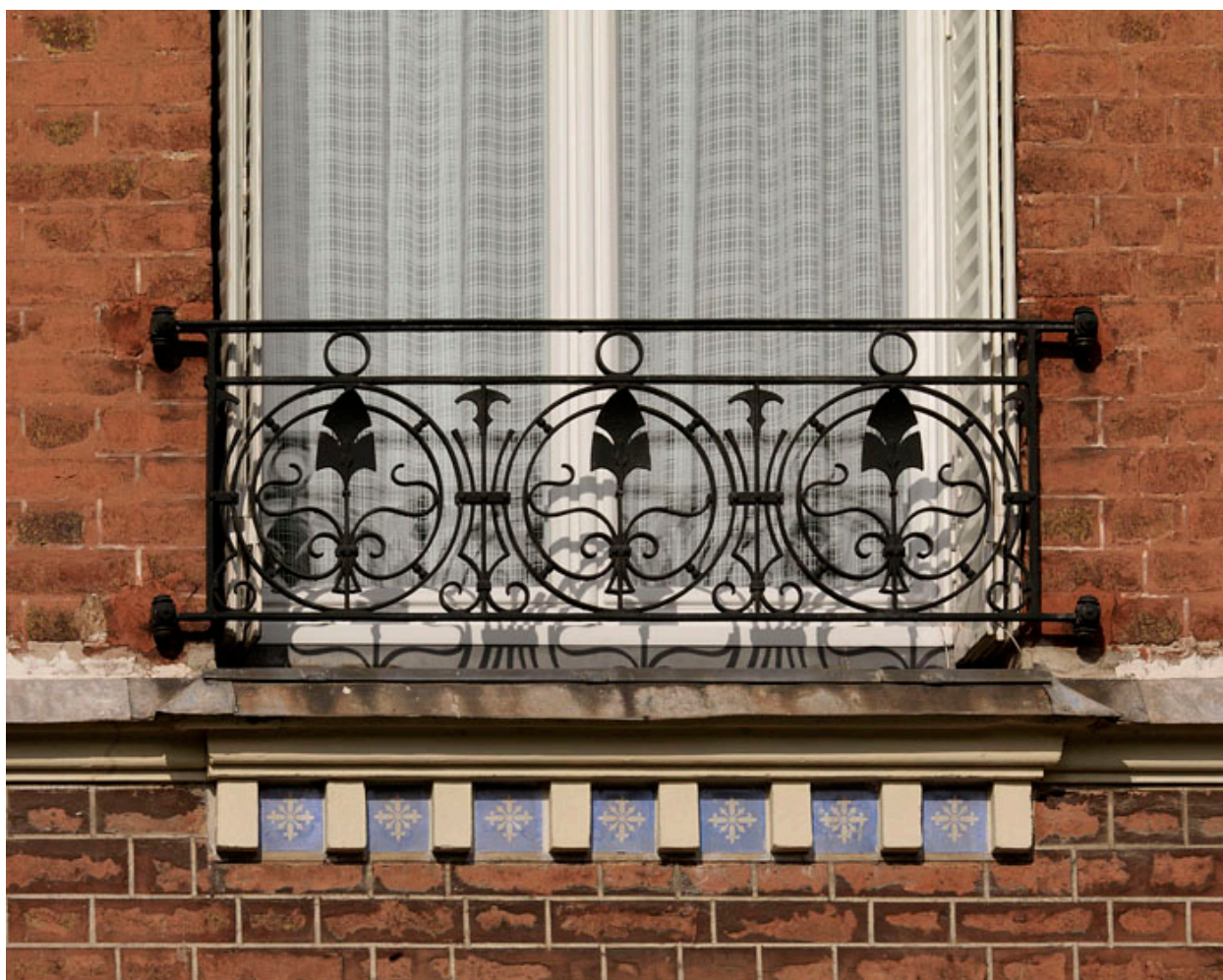
Maison n°1 Villa des Sureaux : détail du garde corps de l'une des baies.
