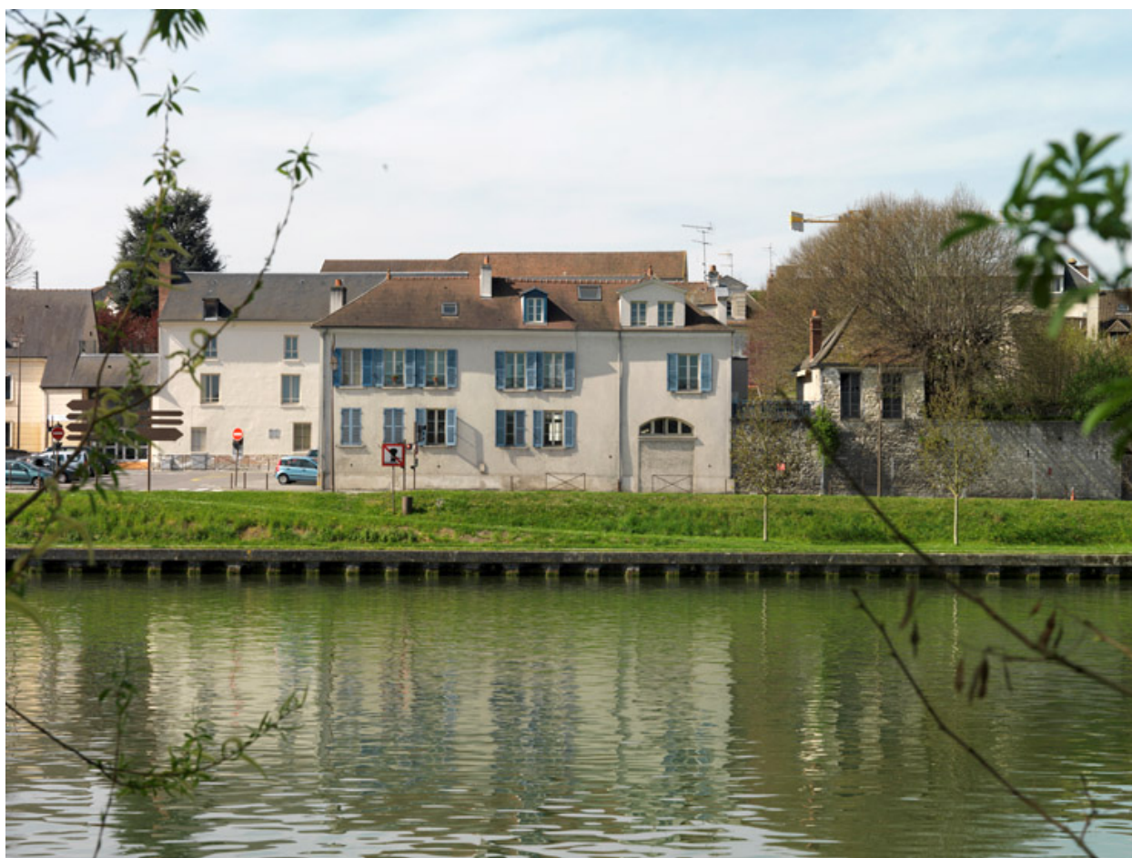
Vue de la maison dans son site, depuis l'île de Limay.
