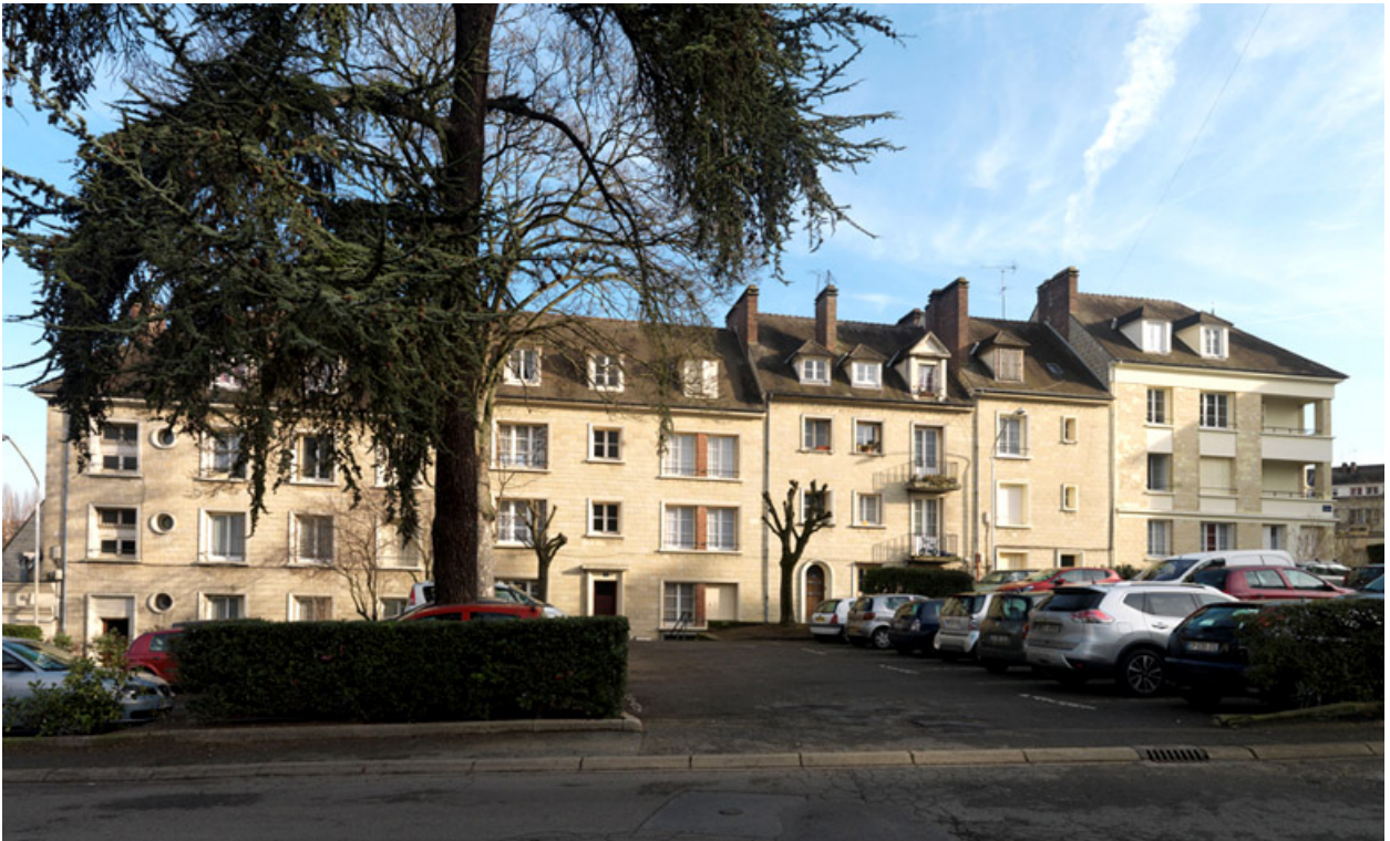
Les immeuble de l'îlot A, 1-11 rue Famille Salomon. Façade principale.
