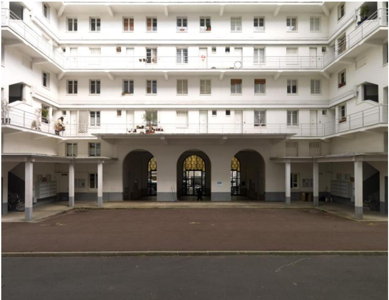
Vue des coursives (arrière du bâtiment principal)
