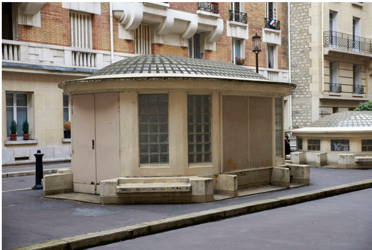
Vue du lanterneau situé à l'entrée du square Delormel.
