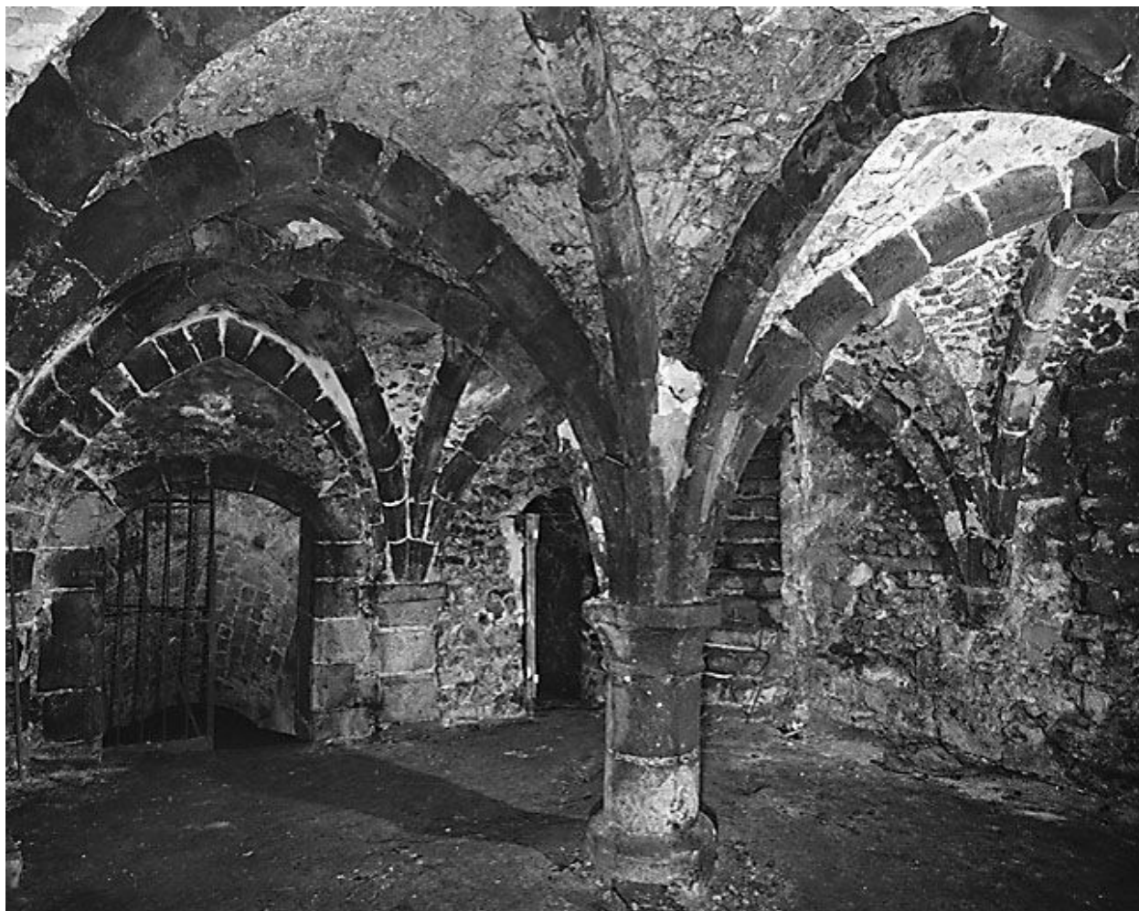
Vue d'ensemble du premier niveau de cave.
