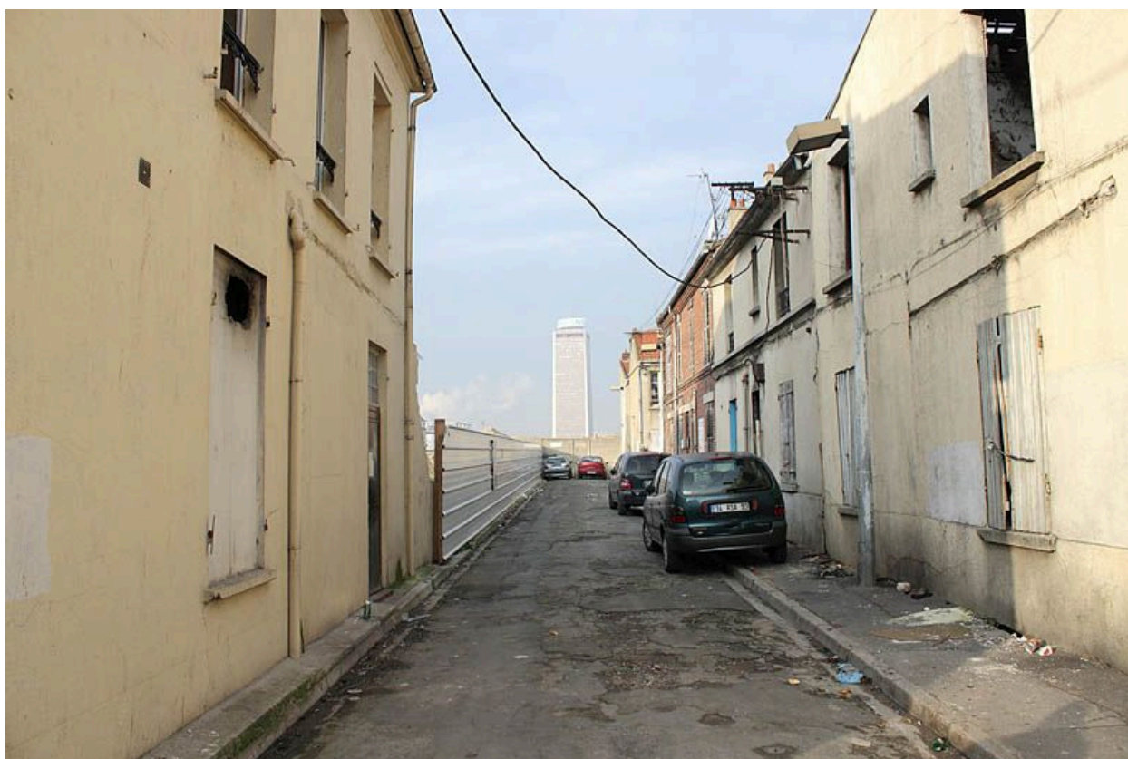
93, Saint-Denis, impasse Queune. Vue générale.
