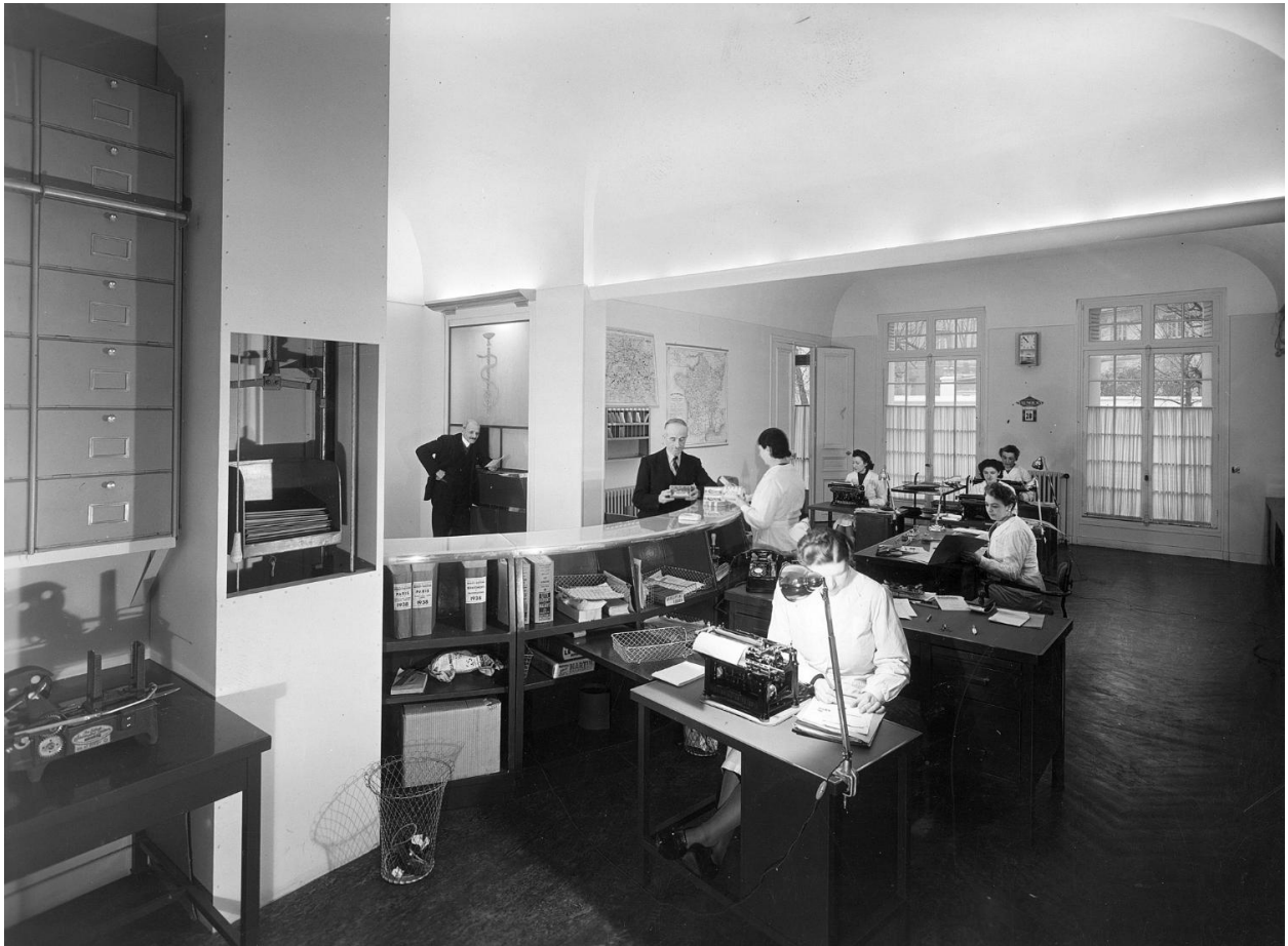
Hôtel particulier, transformé en bureaux, 11 rue Galvani 75017 Paris. Rez-de-chaussée, fenêtres côté jardin.
