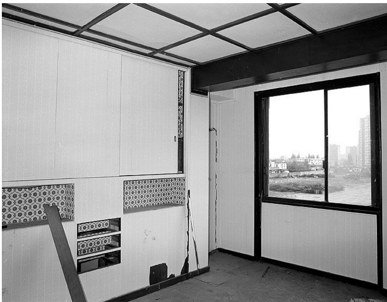
Tour 1, façade ouest, cuisine. Campagne photographique, lors de la destruction du bâtiment en 1976.
