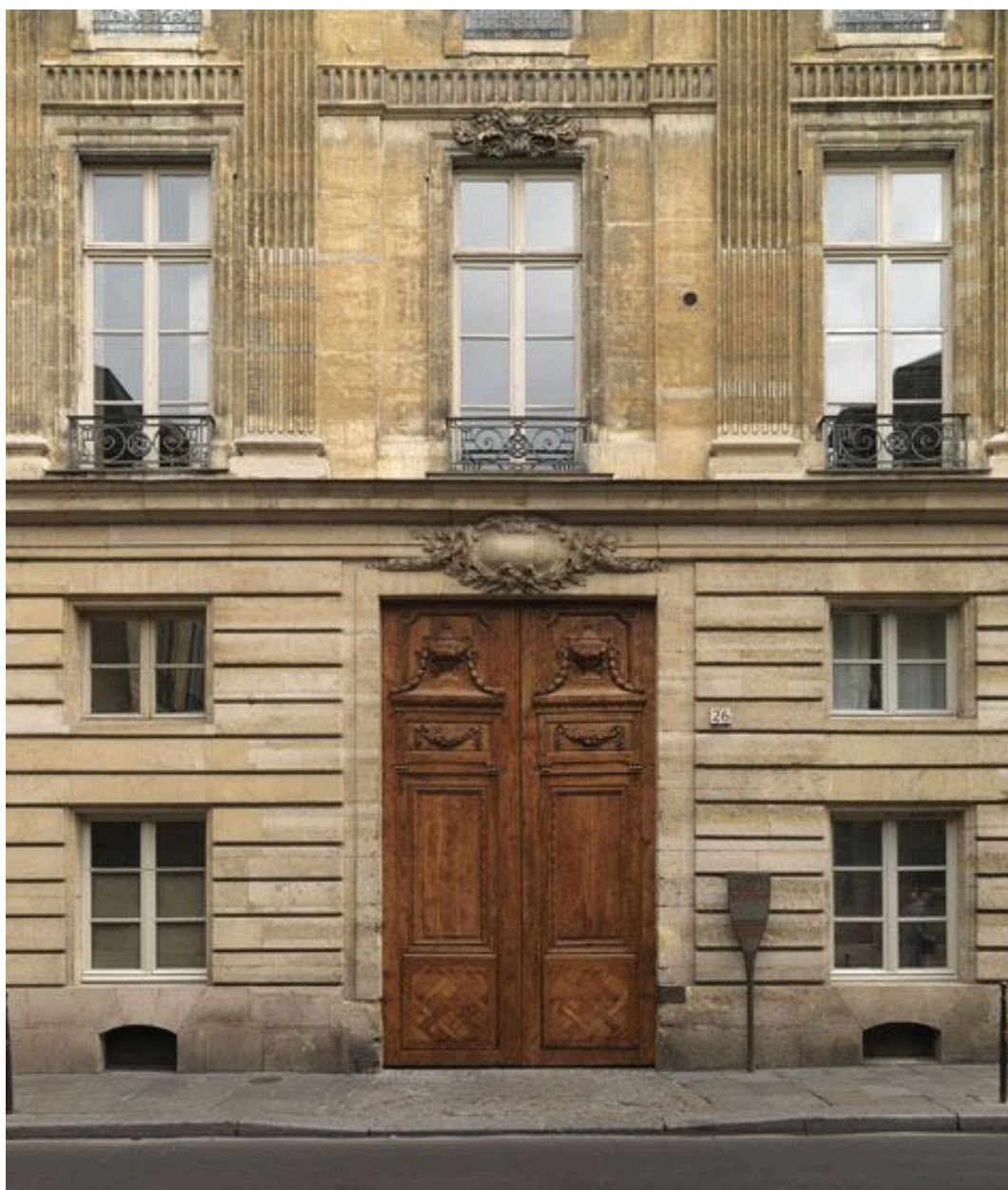
La façade sur rue : détail.
