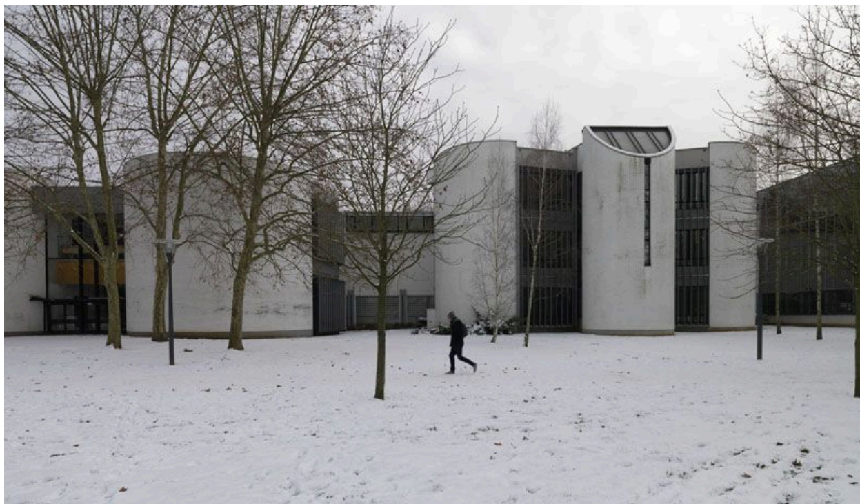
Vue des façades donnant sur le parc de la Préfecture.
