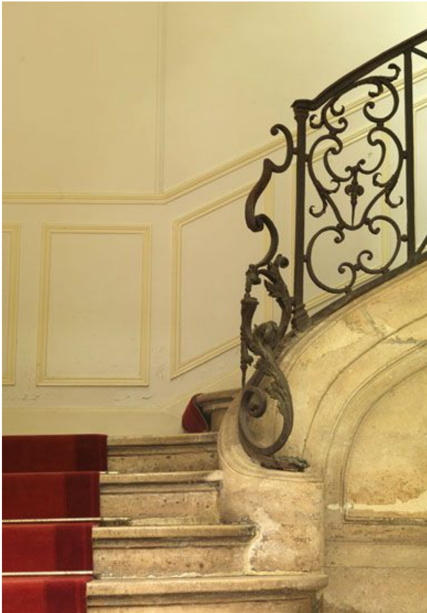
La console de départ, vue de face.
