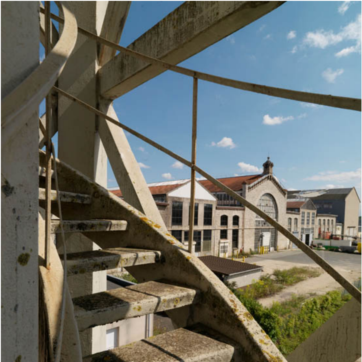
Vue sur la façade de l'usine (Paul Friesé) depuis l'escalier du château d'eau (1902) en ciment armé.
