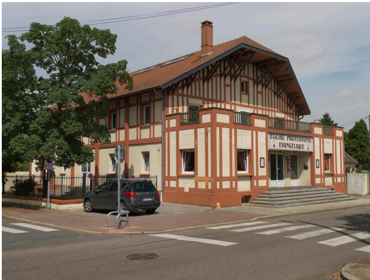
Vue générale du Casino.
