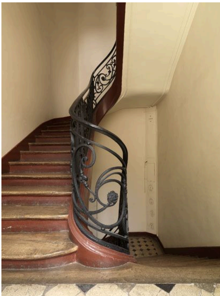
Partie tournante de la rampe.
