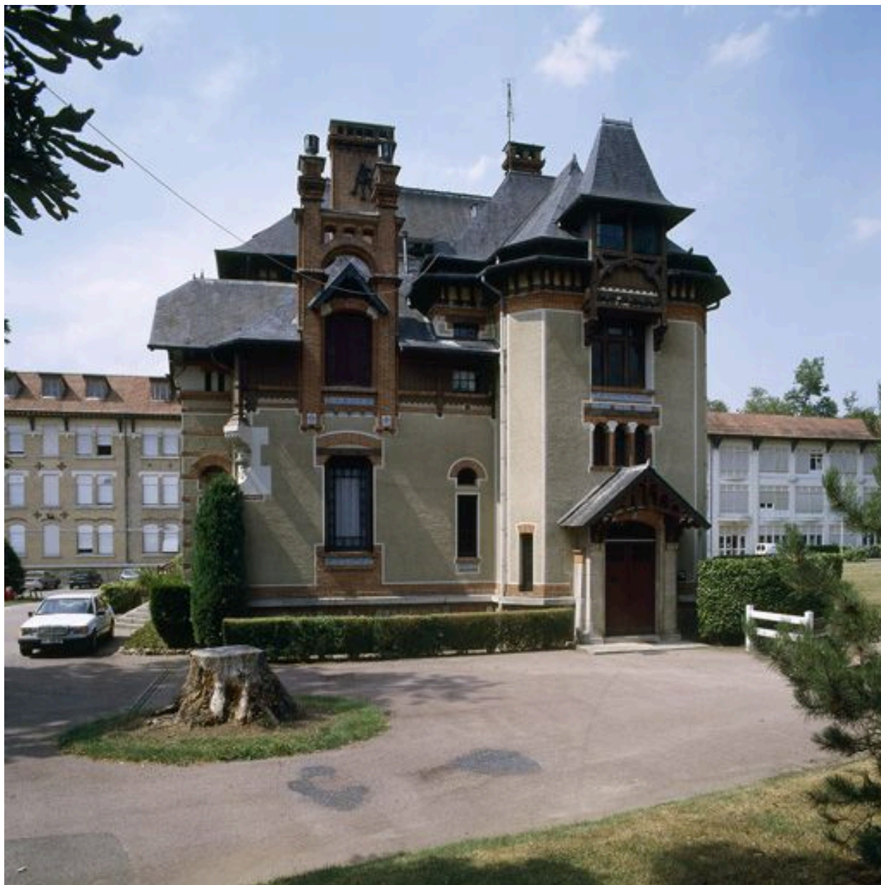
Vue de la façade arrière.
