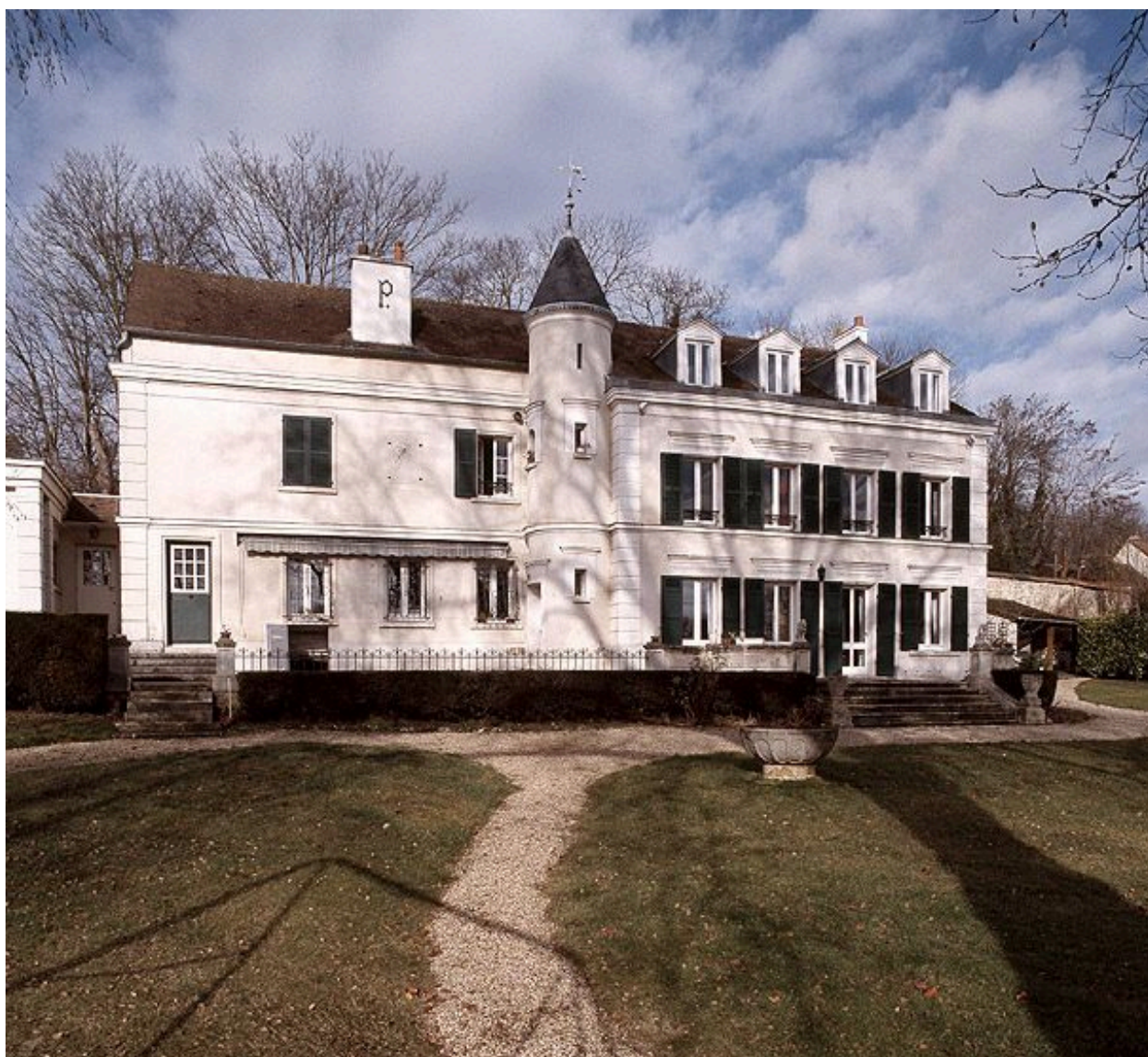
Vue d'ensemble de la façade sur jardin tournée vers la Seine.
