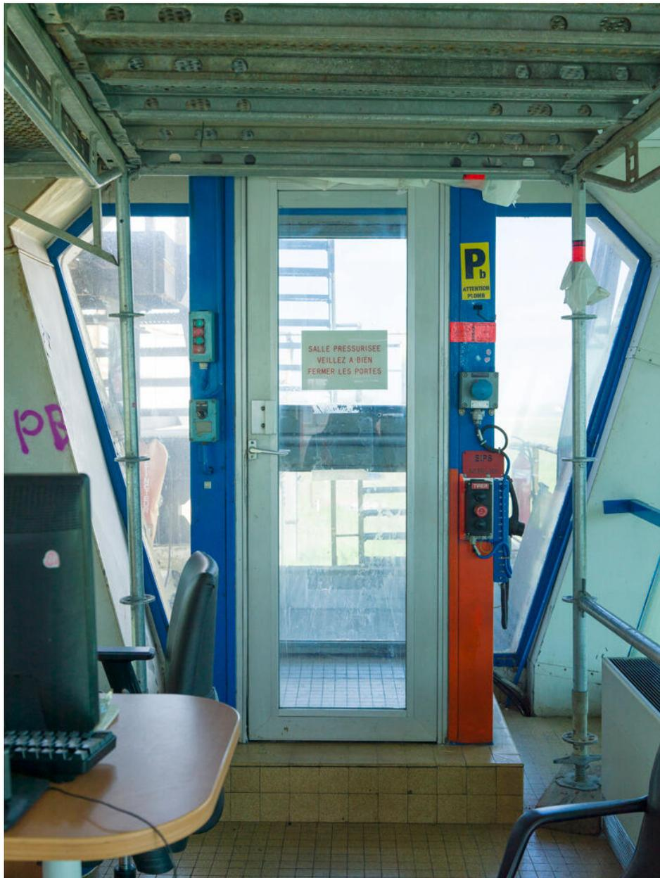
Chargement poste fer (Unité 540). Poste de commande. Derrière la porte, SAS d'entrée (local pressurisé). Une légère surpression suffit à empêcher la pénétration éventuelle des gaz, en cas de fuite.
