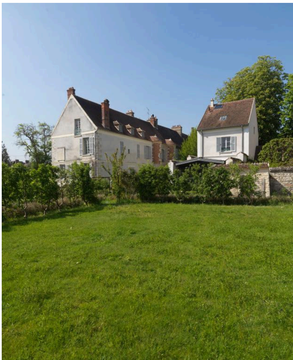
Vue du bâtiment principal et du pavillon
