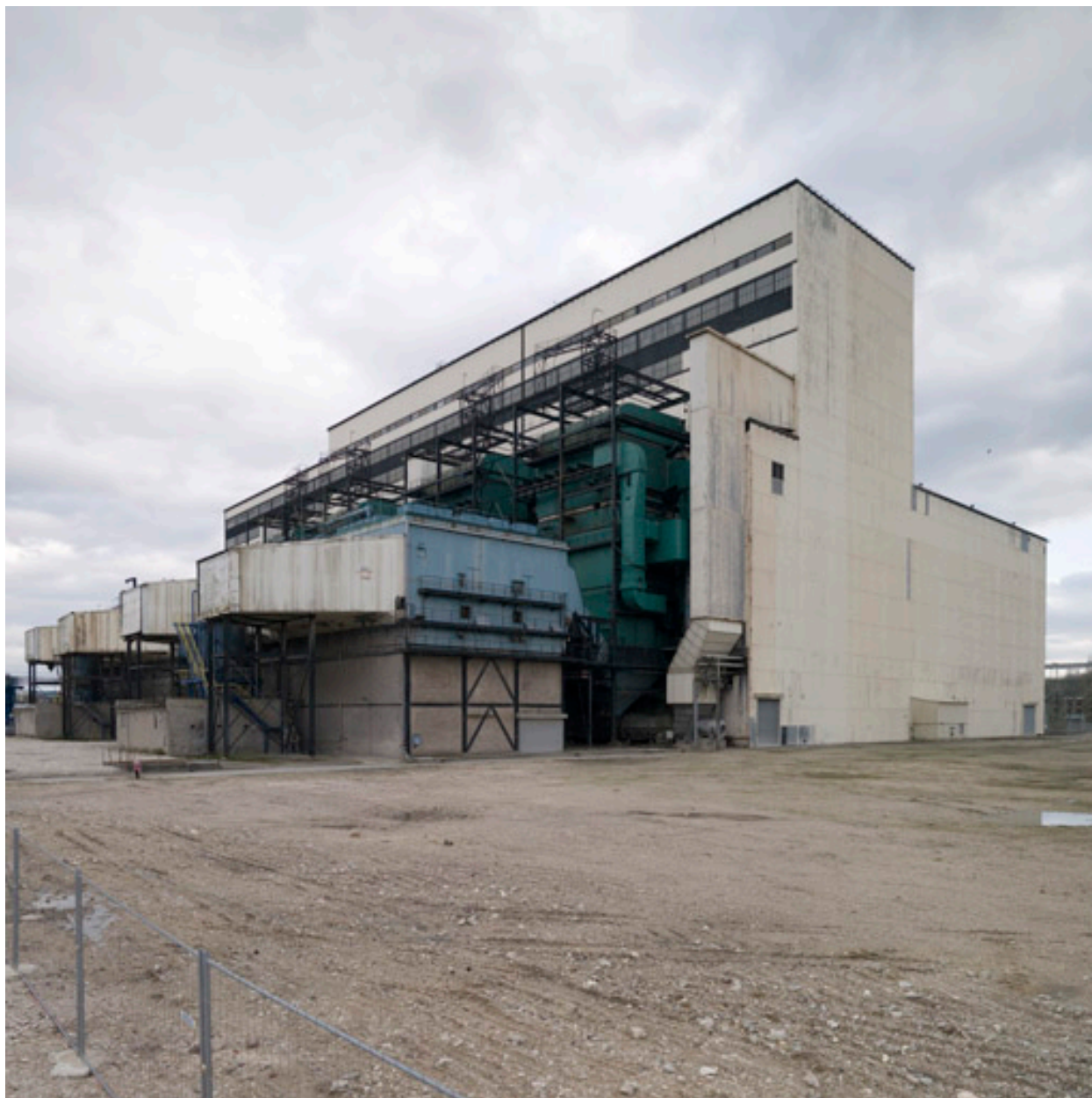
Vue extérieure. arriere du bâtiment.
