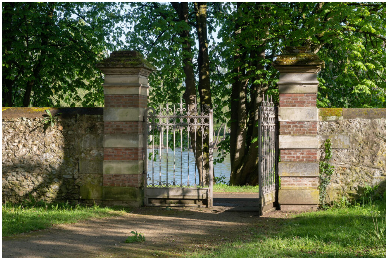
Portail sur le chemin de halage.
