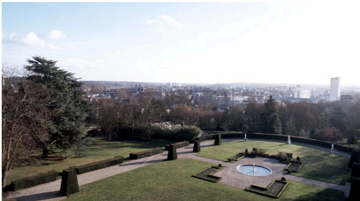
Panorama vers le sud-est, sur les jardins et la ville de Melun, depuis l'hôtel de la préfecture.
