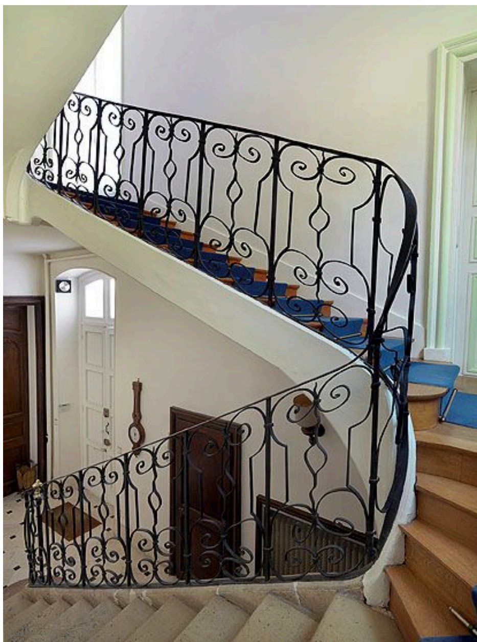
La rampe de l'escalier.
