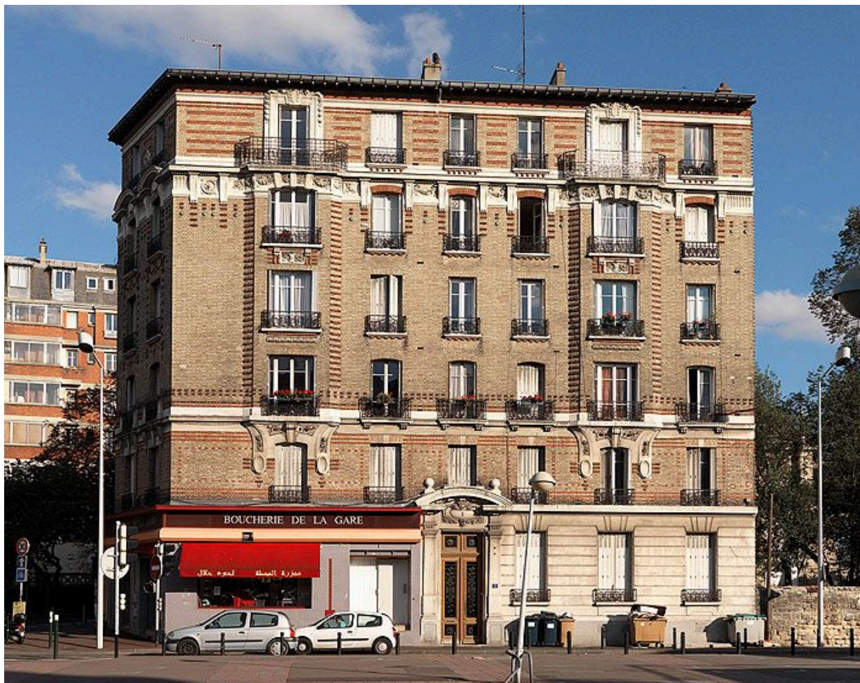
92, Nanterre, immeuble,3 boulevard de la Seine . Façade antérieure.
