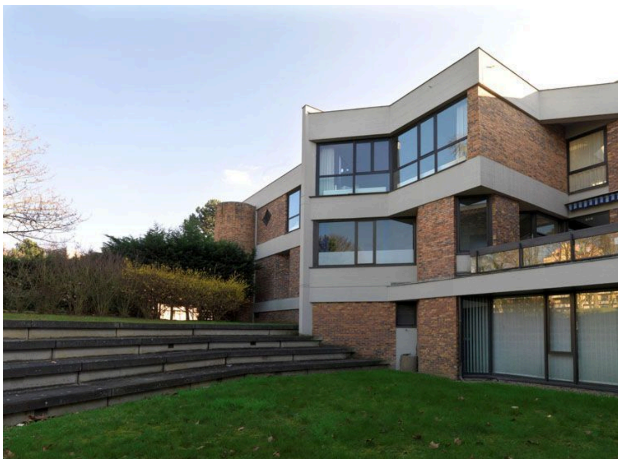
Vue des gradins donnant sur les salles récréatives du sous-sol.
