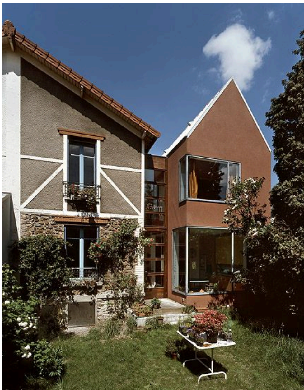
Vue d'ensemble depuis le jardin de la petite maison et de son extension datant de l'an 2000, 34 rue de l'Amiral Courbet.
