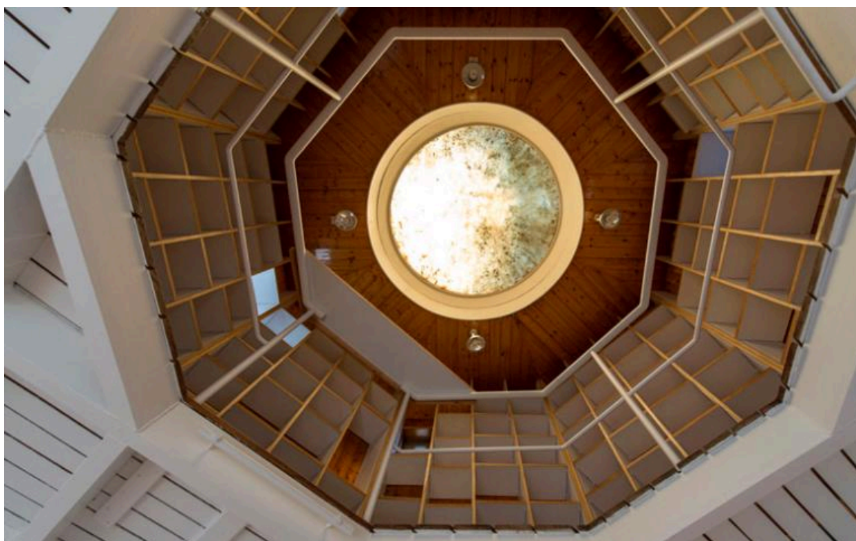
vue en contre-plongée de la verrière couvrant le pavillon octogonal coté sud
