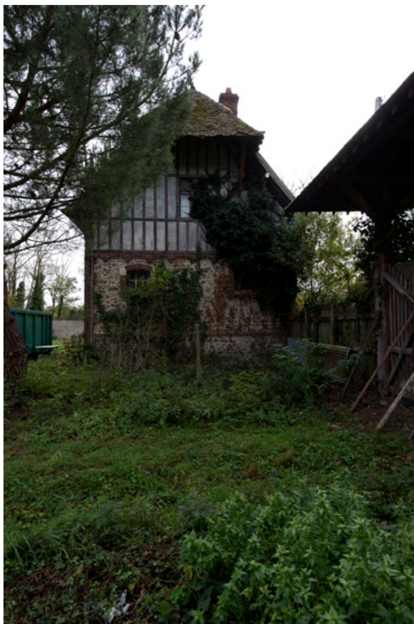
Pignon de la grange à gauche du portail ouest.
