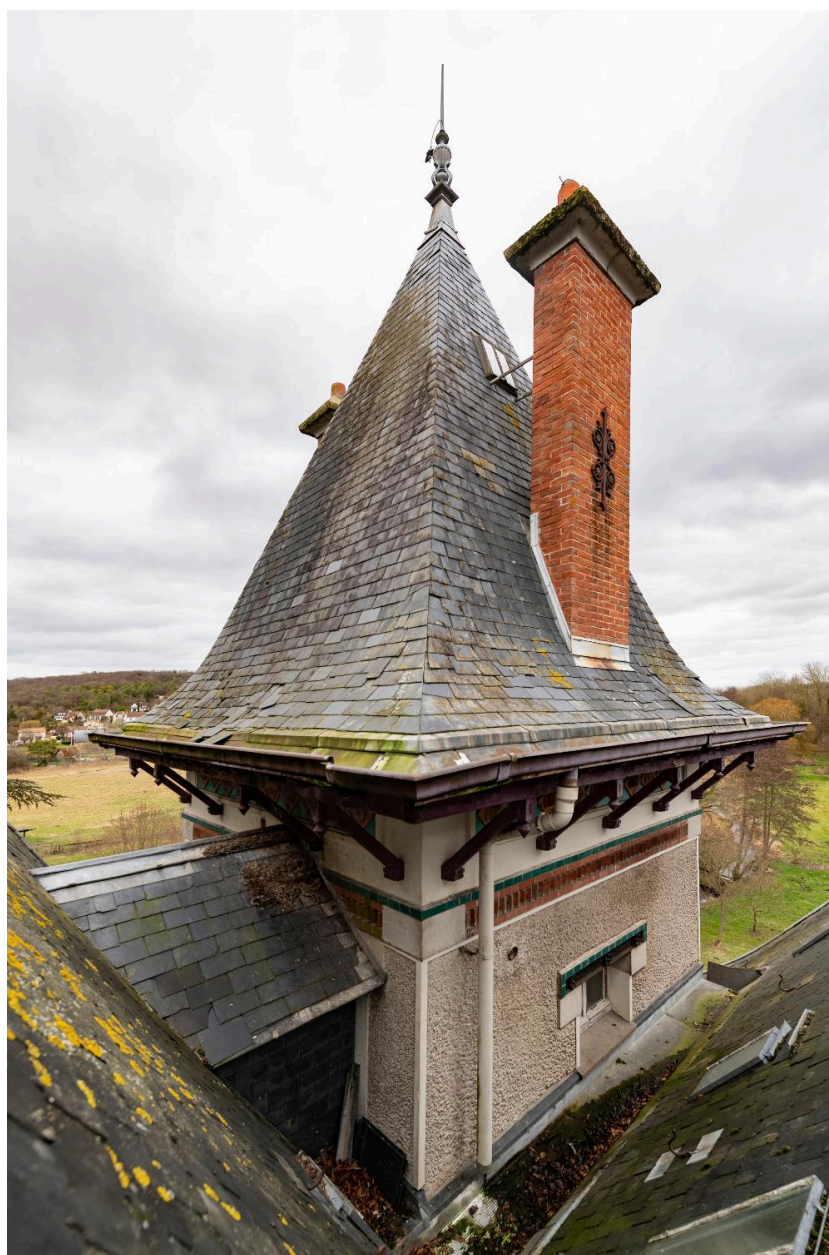
Toiture en pavillon de la tour d'escalier
