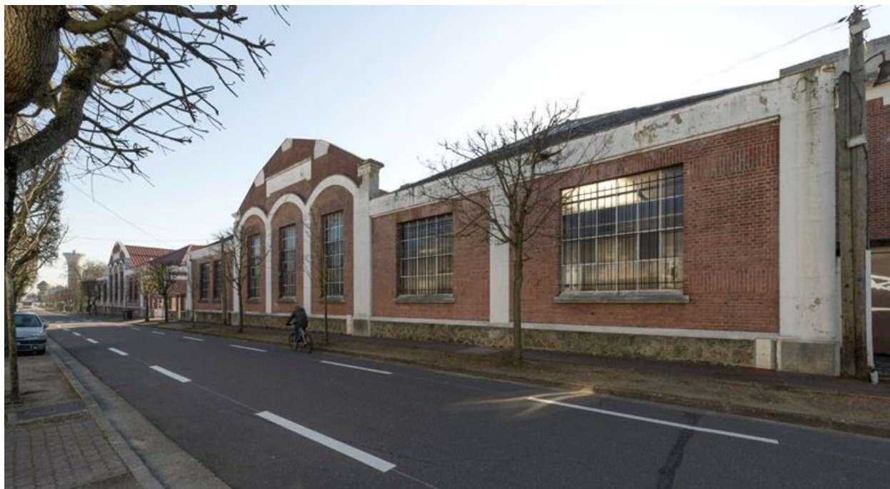
Usine, Mantes (boulevard de ) 20. Vue générale de l'usine.
