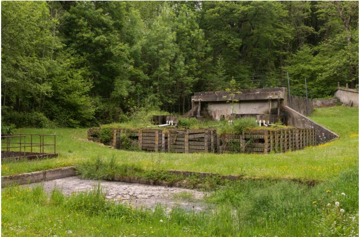
bassin d'épuration. Au 1er plan : bac de séchage des boues, au 2e plan : bac de nitrification et fosse de décantation
