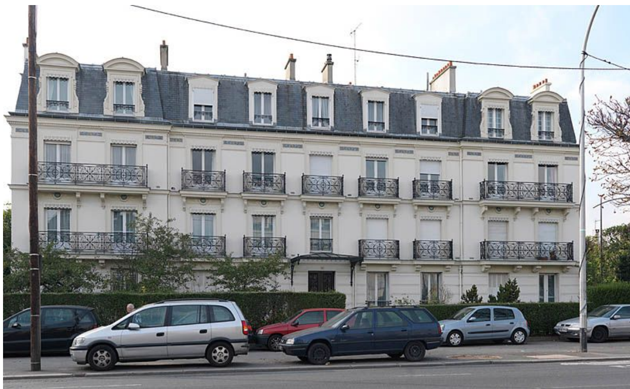
Thiais, immeuble, 11 boulevard de Stalingrad. Elévation antérieure.
