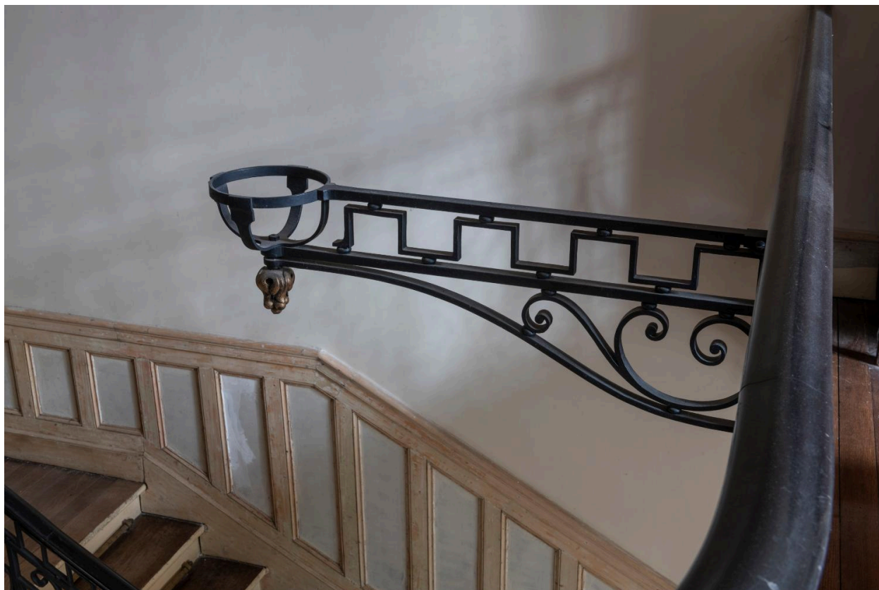
Hall d'entrée, suspension au-dessus de l'escalier
