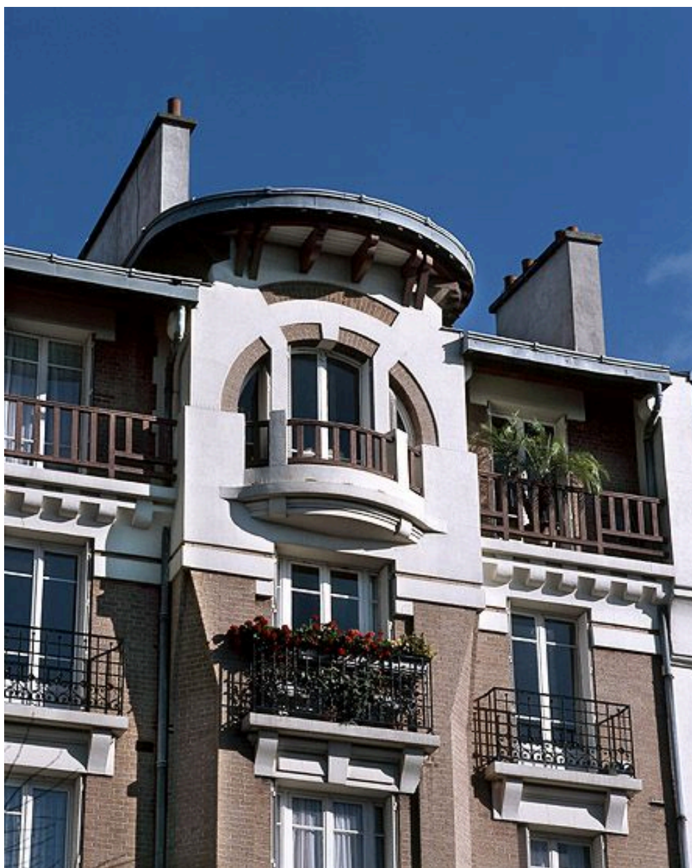
Immeuble, 3 rue Victor Hugo. Détail des loggias en partie haute.
