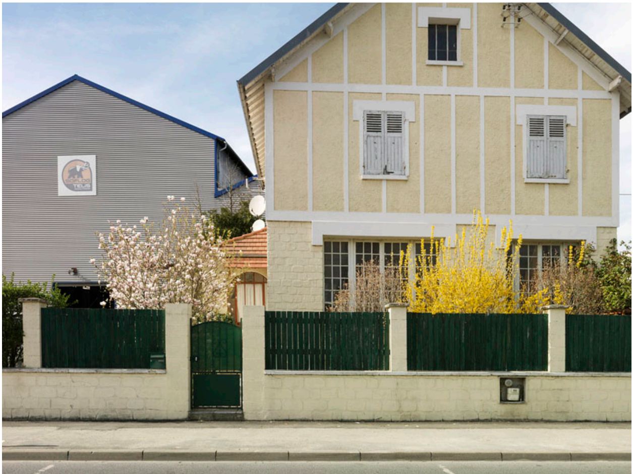
Persan. Le quai de l'industrie. Maison individuelle et bâtiment industriel. Élément de phrase urbaine.
