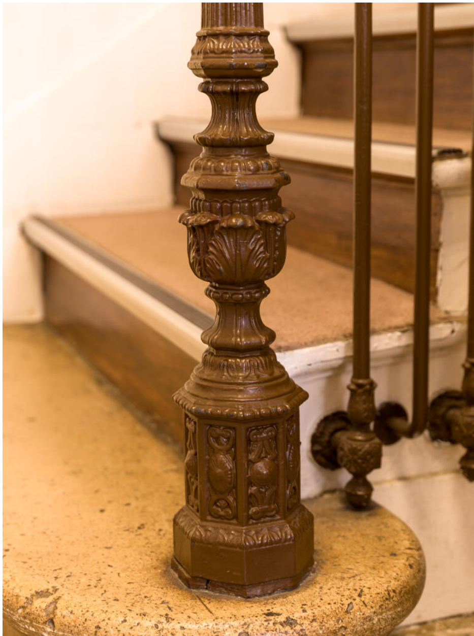
Détail du départ de rampe.
