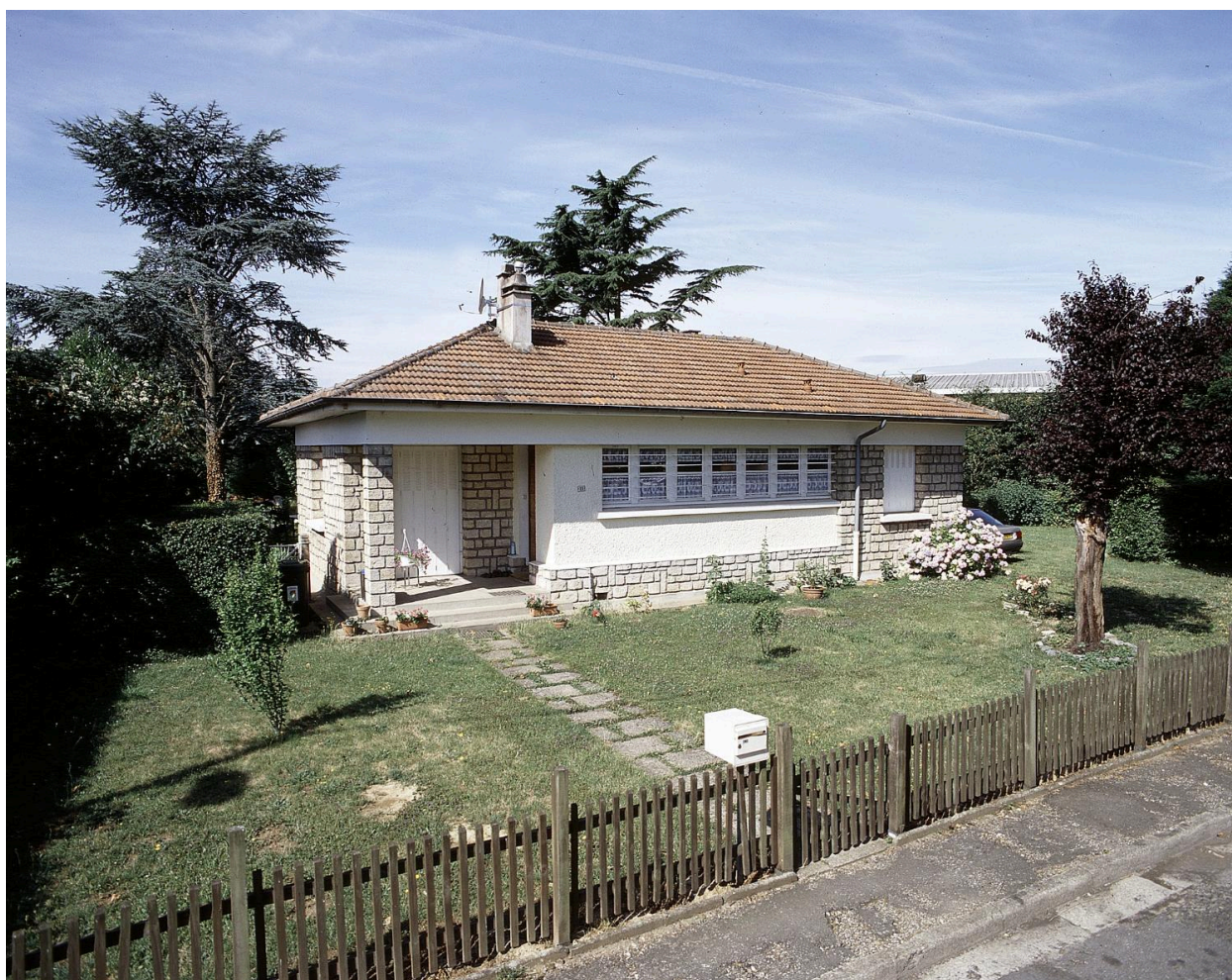
Vue d'ensemble d'un pavillon du type I 3 C situé 11, rue Alexandre-Collenot.
