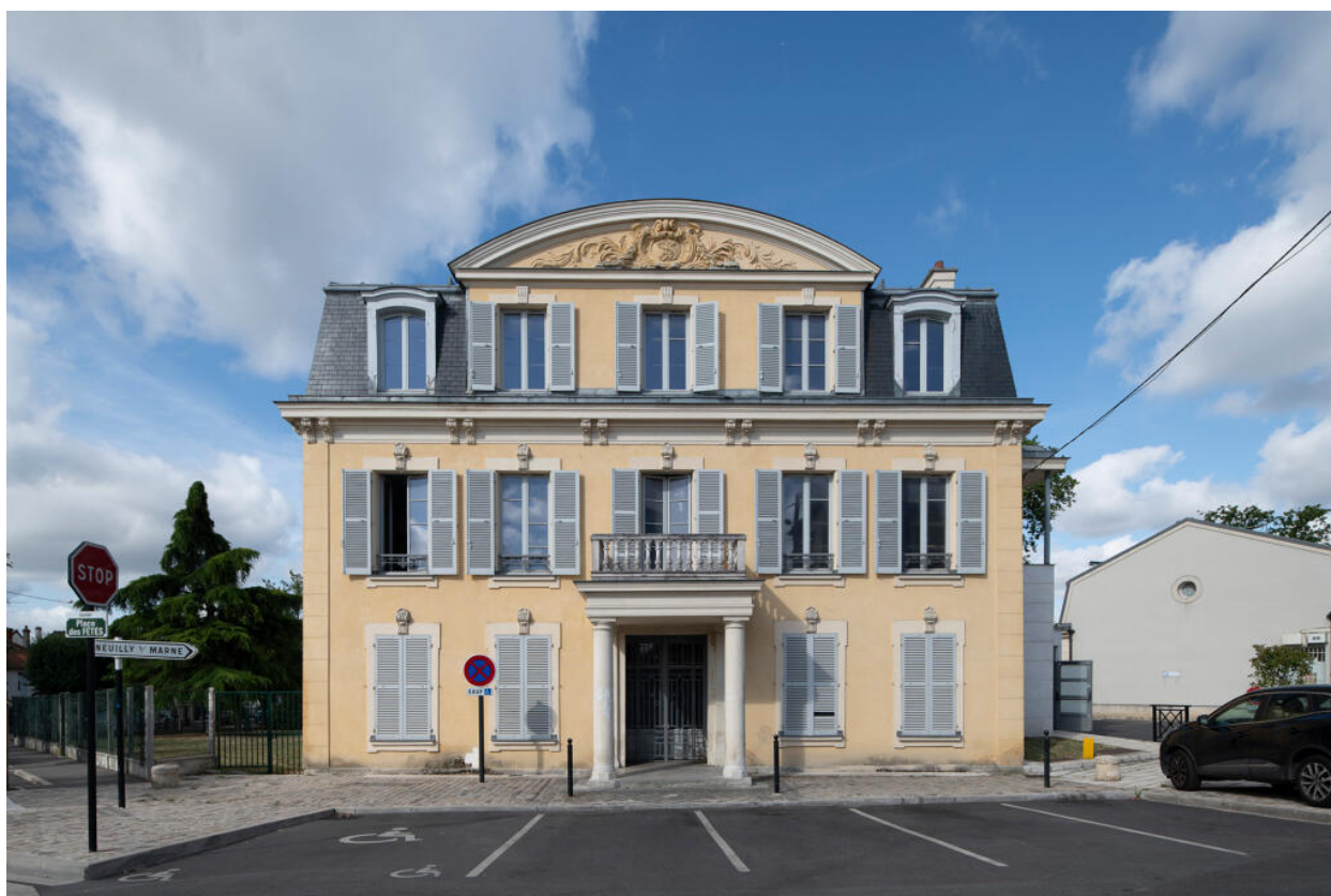
Vue générale de la façade principale.
