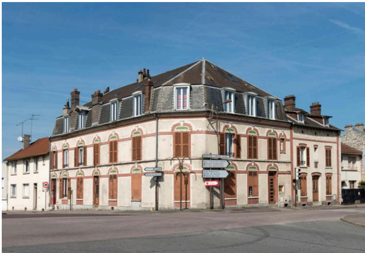
Maisons de bourg, 86 rue Carnot et 36-38 avenue de la Division du Général Leclerc.
