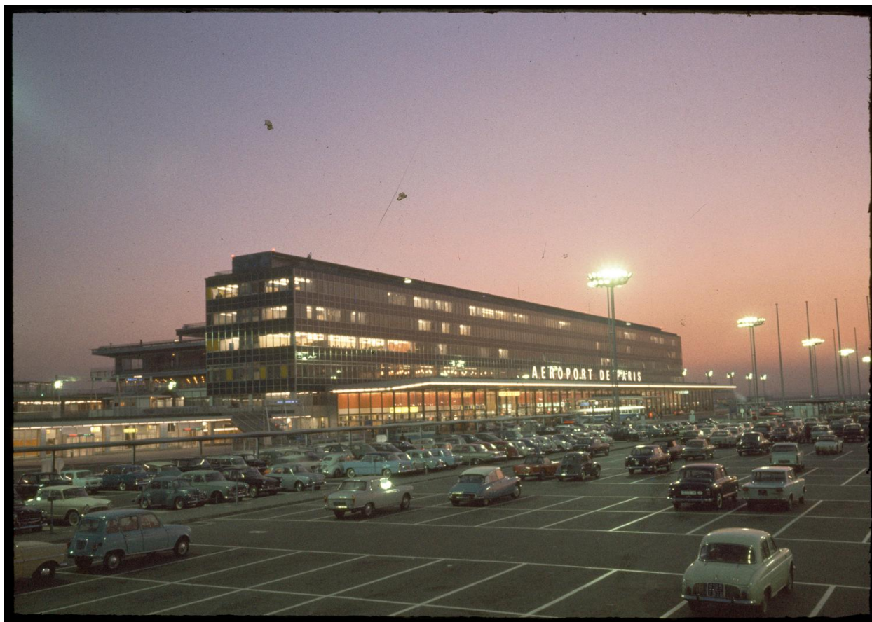
1961, les Installations terminales vues depuis le nord est.
