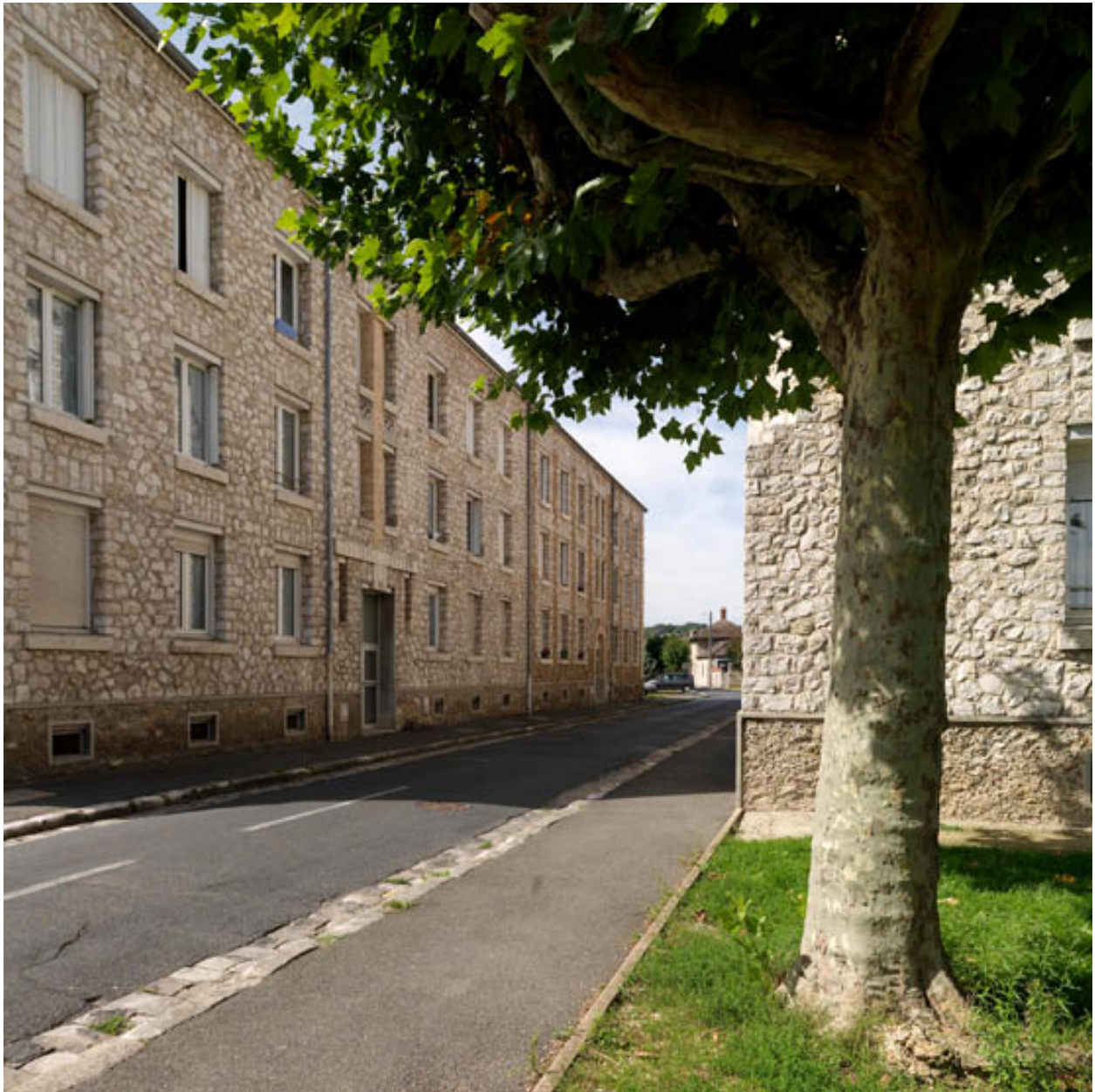
Ancienne rue du Pas-Rond, actuelle rue de la Libération. Immeuble en meulière blanche et brique claire construit en 1903
