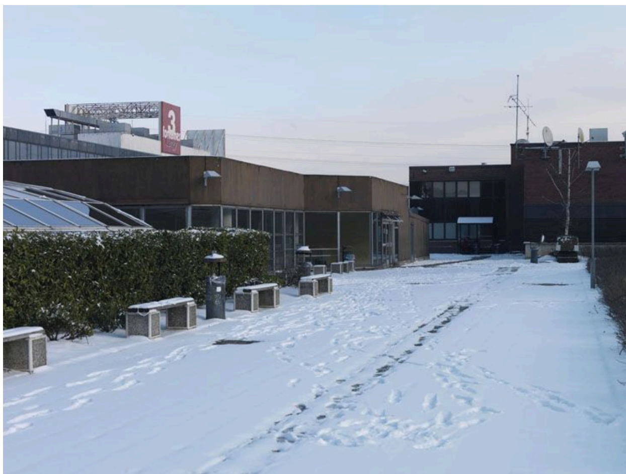
Vue sur les jardins situés sur le centre commercial.
