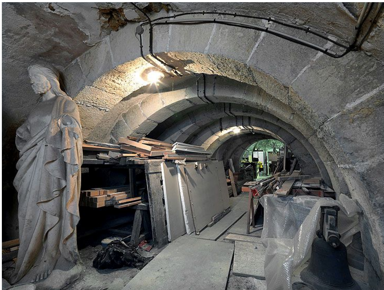
Vue d'ensemble de la cave en berceau à arcs doubleaux qui s'étend sous la chapelle, prise depuis l'est.
