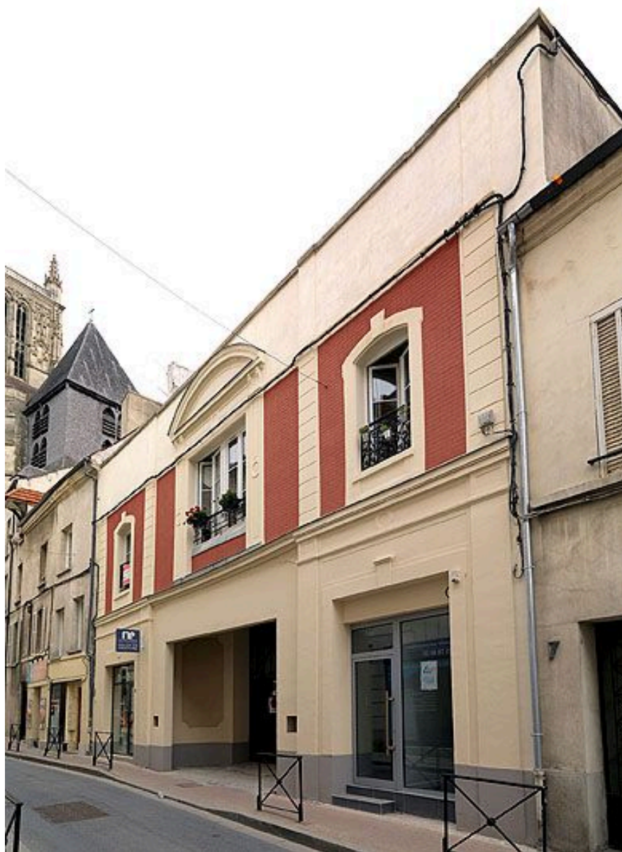
Vue de l'élévation latérale, donnant sur la rue Martimprey (ancien atelier).
