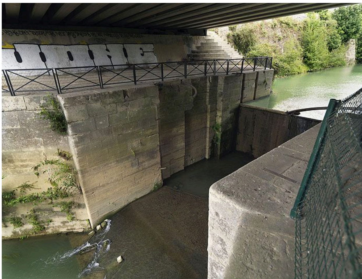
Le sas d'entrée de l'écluse, sous le pont de Cornillon.
