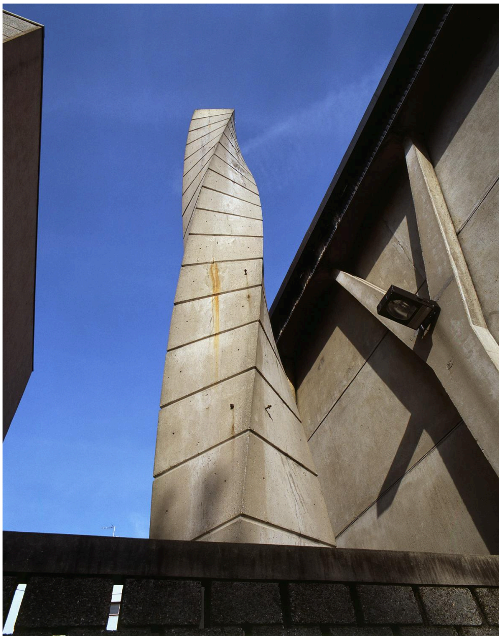
Détail de la cheminée
