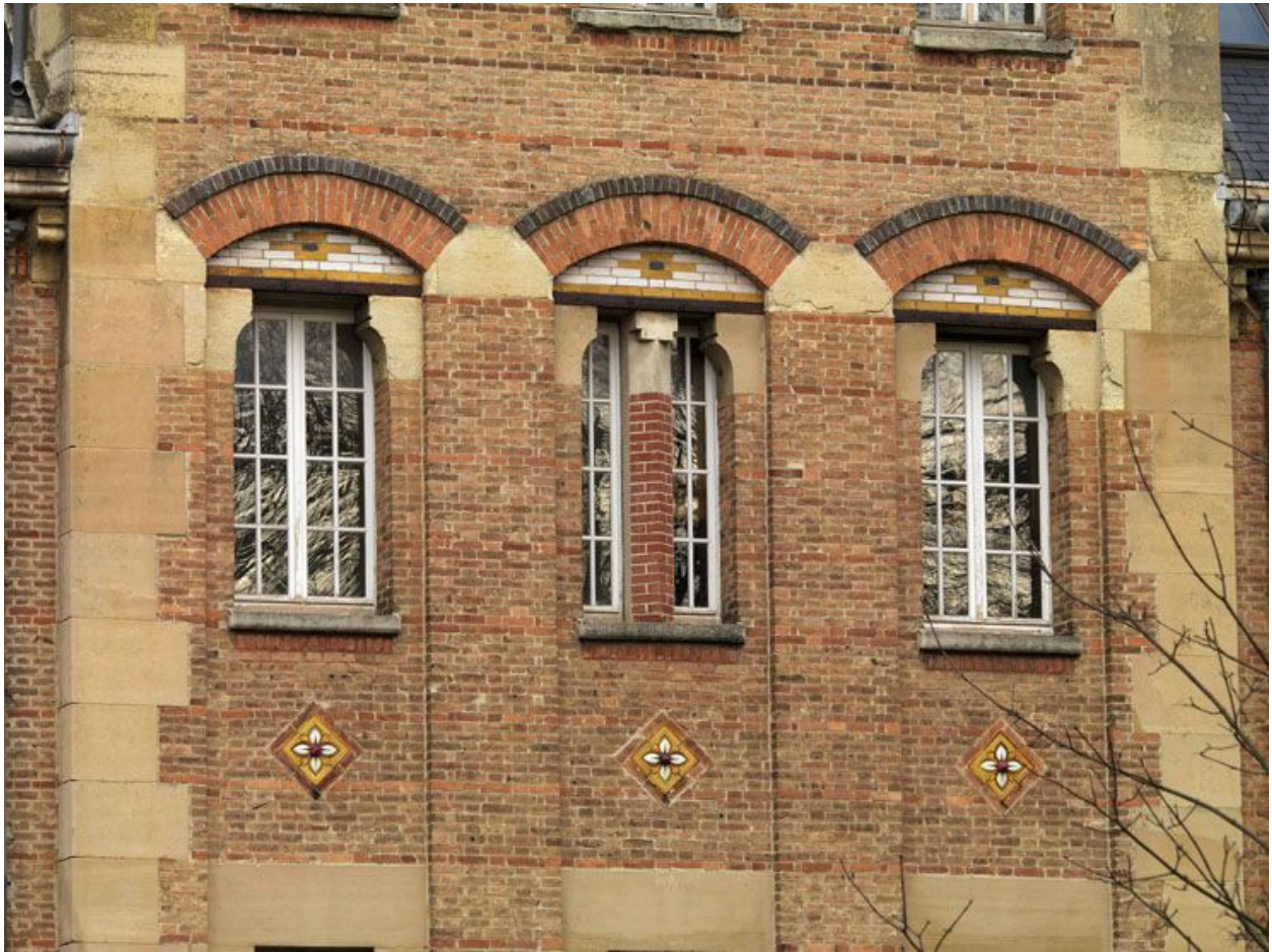
92, Sceaux, lycée Lakanal, 3-7 avenue du Président-Franklin-Roosevelt. Infirmerie : baies du 2e étage.
